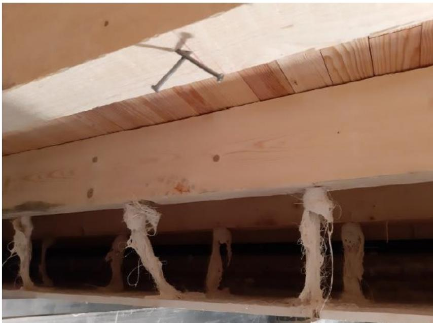
*Mise en œuvre des polochons sous plancher bois.*
